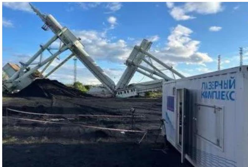
(кранов-перегрузателей) выведенных из эксплуатации, была использована уникальная установка – Мобильный лазерный комплекс (МЛК).
