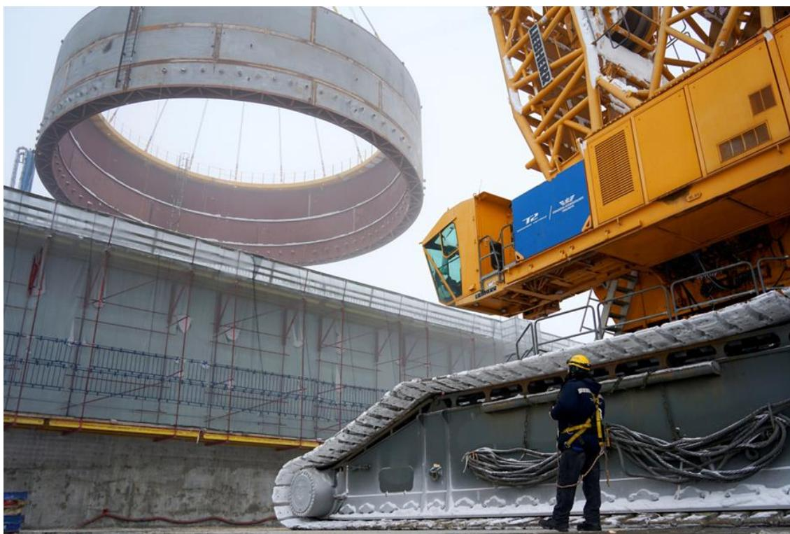
Ограждающая конструкция – внешняя часть корпуса реакторной установки. Она обеспечивает удержание теплоизоляционного бетона, формирует дополнительный локализующий барьер защиты, который следует за границей контура теплоносителя. На ее поверхности
