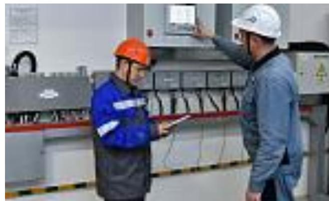
Госкорпорации «Росатом») на резервную дизельную электростанцию (РДЭС) установлены датчики контроля температуры подшипников и охлаждающей воды цилиндров. При работающем дизель-генераторе информация с датчиков в режиме реального времени теперь поступает на пункт контроля, что позволяет более детально отслеживать техническое состояние РДЭС.
