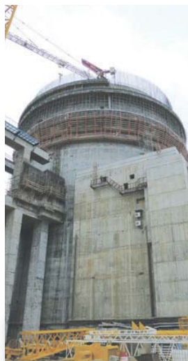
РЕАКТОРНОЕ ОТДЕЛЕНИЕ НОВОЙ АЭС пока еще возводится. При его осмотре дозиметры не понадобились
